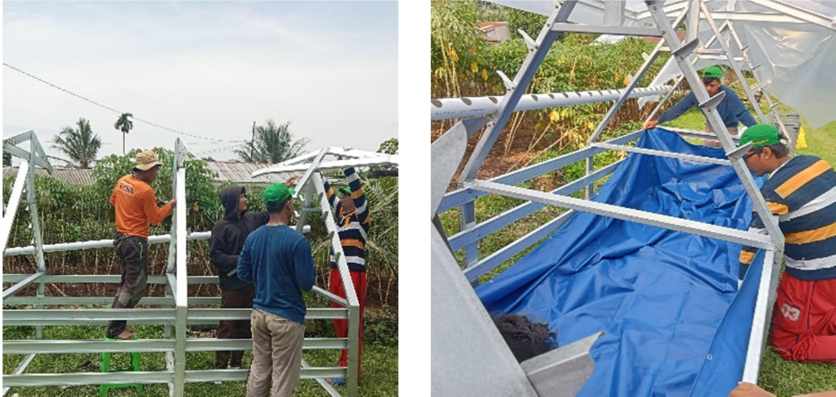
Gambar 1. Proses Pemasangan rangka, pipa dan terpal kolam pada aquaponik
