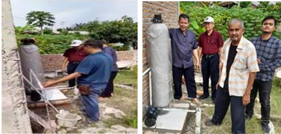
Gambar 2. Pemasangan pompa dan persiapan saringan
