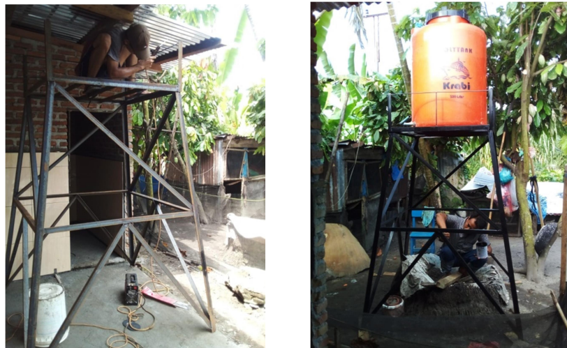
Gambar 3. Pekerjaan Instalasi Menara Air
