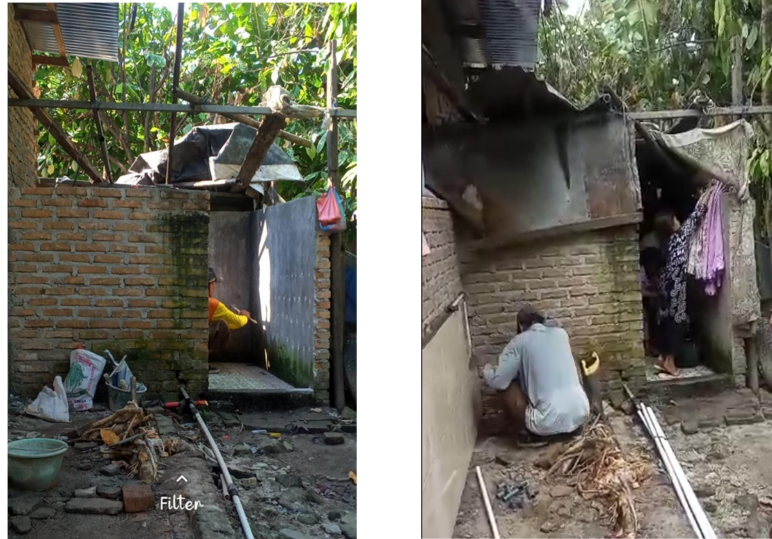
Gambar 2. Pengerjaan Perbaikan Toilet dan dan Pembuatan Tempat Wudhu
