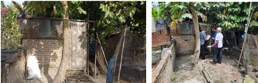
Gambar 1. Kondisi Toilet Saat Survei
