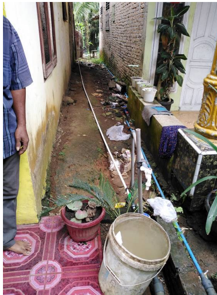
Gambar 2. Instalasi pipa air di rumah penduduk
