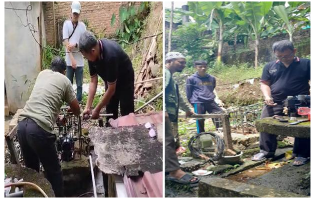
Gambar 1. Pemasangan pompa air
