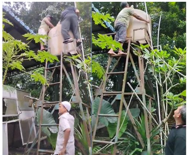
EGambar 2. Pemasangan instalasi pipa ke tandon
