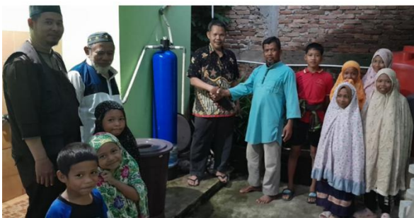
Gambar 4. Serahterima instalasi air bersih dan saringan air
